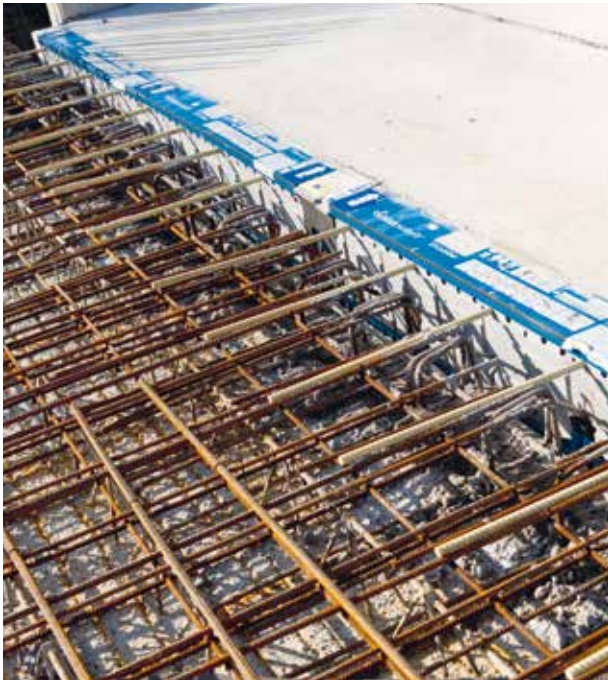
Montage des Fertigteilbalkons auf der Baustelle.
