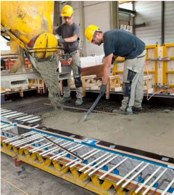
Verarbeitung des Schöck Isokorb® XT-Combar im Fertigteilwerk.
