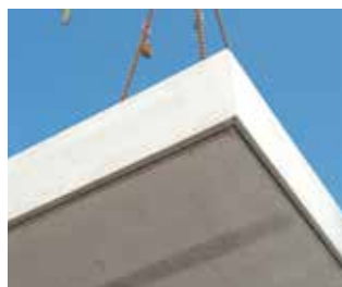
4. Nach Abheben der Platte Dichtleiste entfernen
