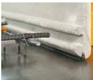
1. Schöck ASE mit Abdichtung auf den Schaltisch positionieren
