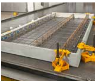
3. Bewehrung einlegen und betonieren
